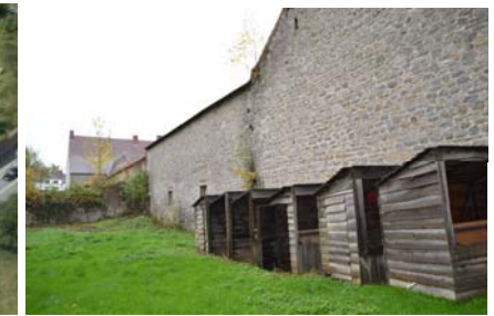
Partie latérale nord des granges côté futurs accès et parking
